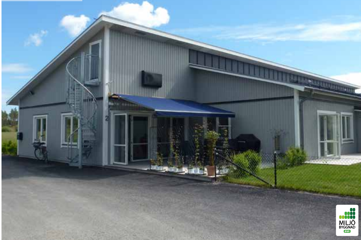
1 LSS Partille Färdigställt 2015
