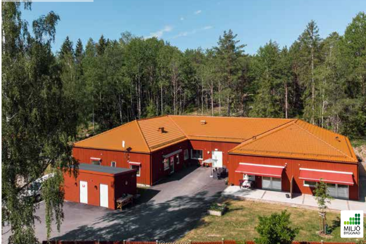
2 LSS Mariefred Byggår 2018
