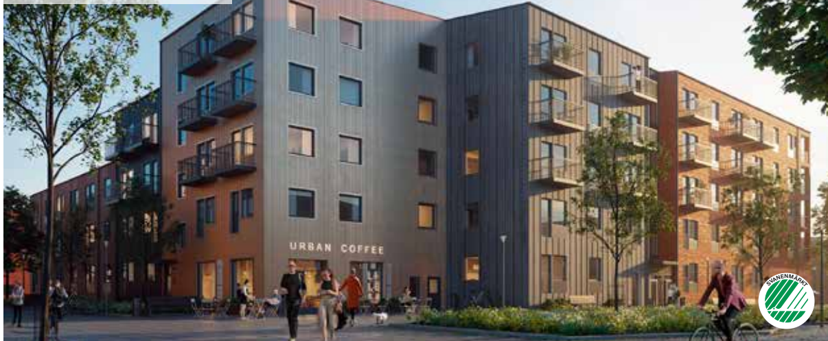
6 Brynäs 19:18, Godisfabriken Färdigställs 2021
