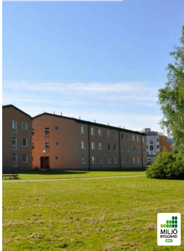
2 Bottenhavet 21 Ombyggnation färdigställd 2021
