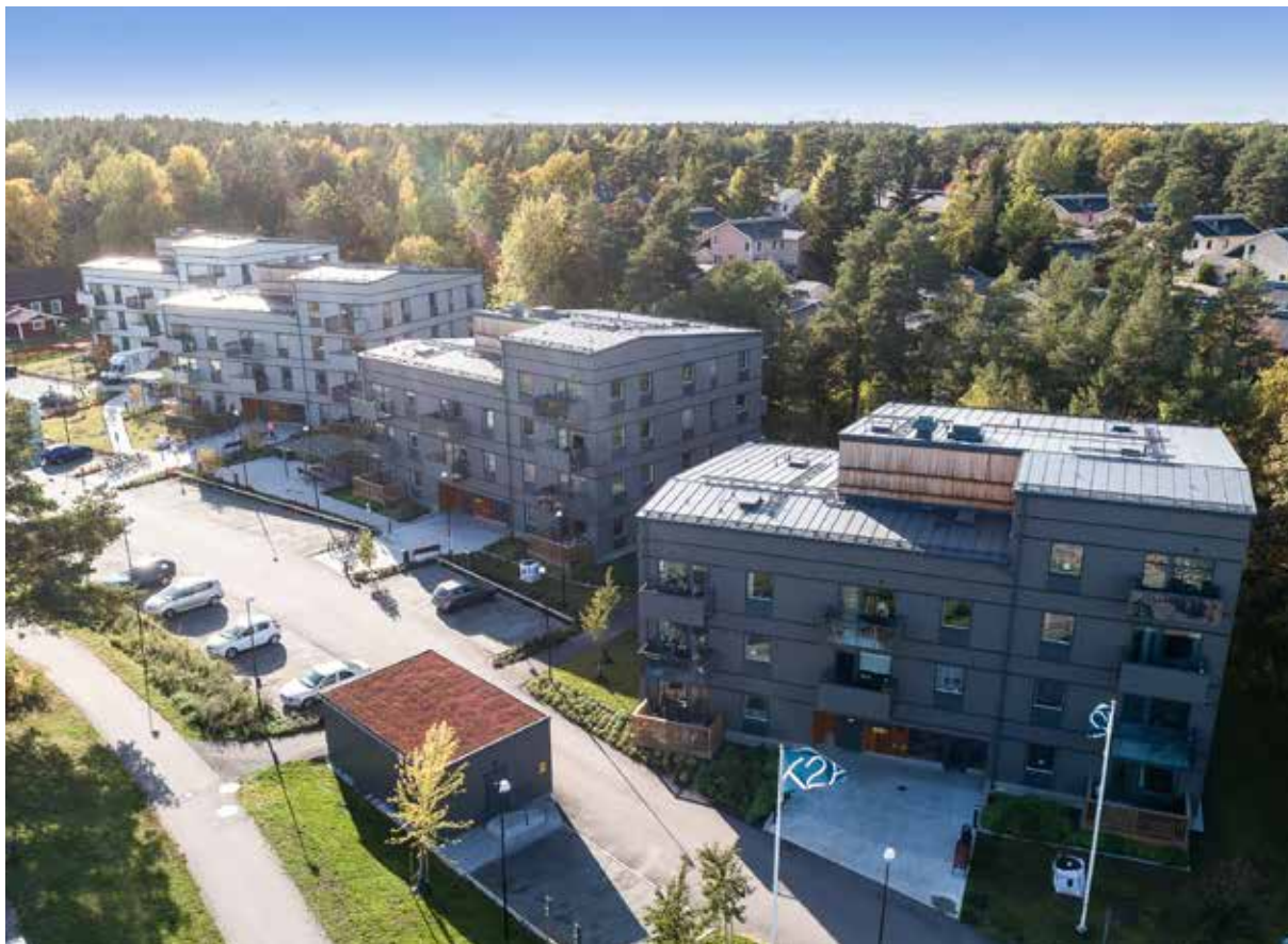
Fastigheten Gånsta 2:106 i Enköping med 80 bostäder miljöcertifierades enligt Miljöbyggnad iDrift under 2021.
