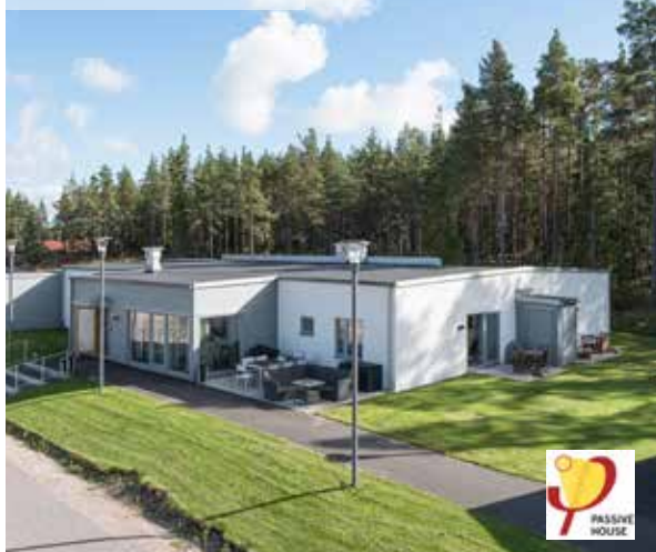
3 LSS Gävle Färdigställt 2014
